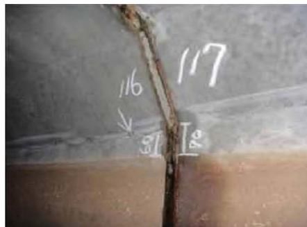
沈下による段差発生
