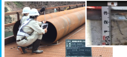
(現場での受注者による材料検収状況)
