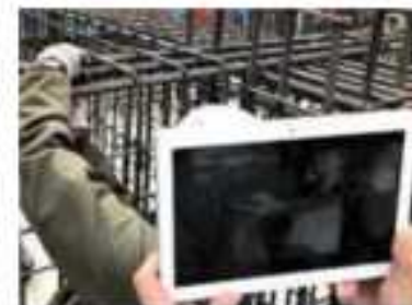
Webカメラを利用した遠隔検査
