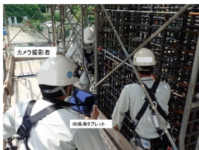
①臨場(受注者)の状況
