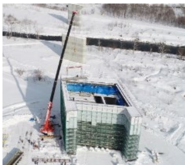
プレキャスト部材の活用
