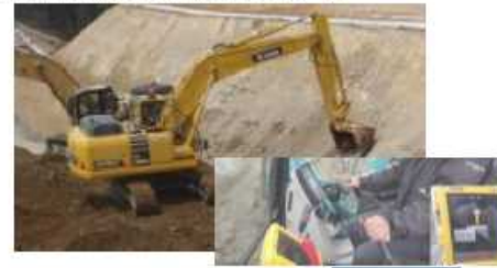
3) ICT建築土工 試行
