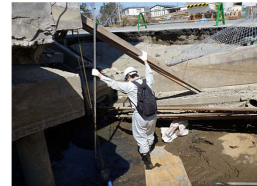
官庁施設の被災状況調査
