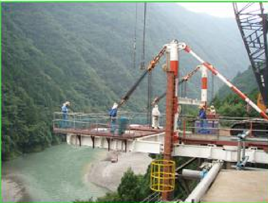
上部工パネル架設
