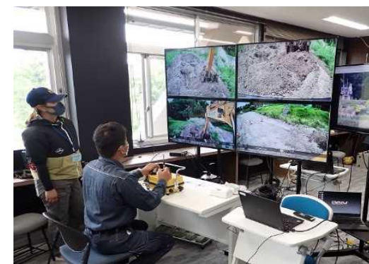
室内でモニターを見ながら遠隔操作
