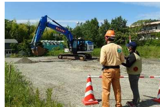
目の前で建機を見ながら遠隔操作
