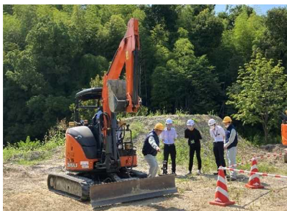
ICT建機(MCバックホウ)の操作
