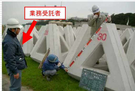
(根固めブロックの材料確認)
