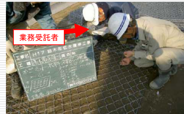
(河川護岸用かごマットの材料確認)
