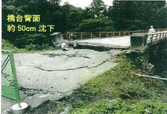
▲橋台周辺の土塊の沈下と橋台等の傾斜
