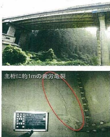
▲主桁の疲労亀裂の事例
