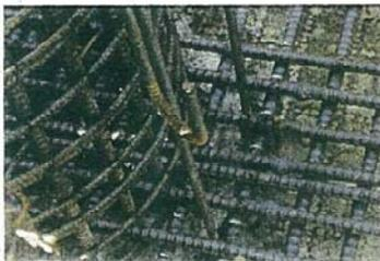
▲杭頭補強鉄筋とフーチング鉄筋の干渉(過密配筋)
