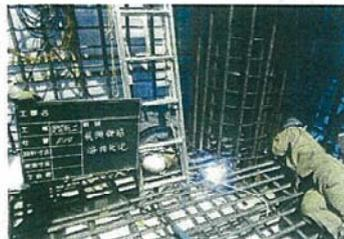
▲溶接による杭頭外周鉄筋の施工状況(品質確保が困難)
