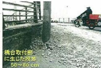
橋台背面盛土の沈下の事例
