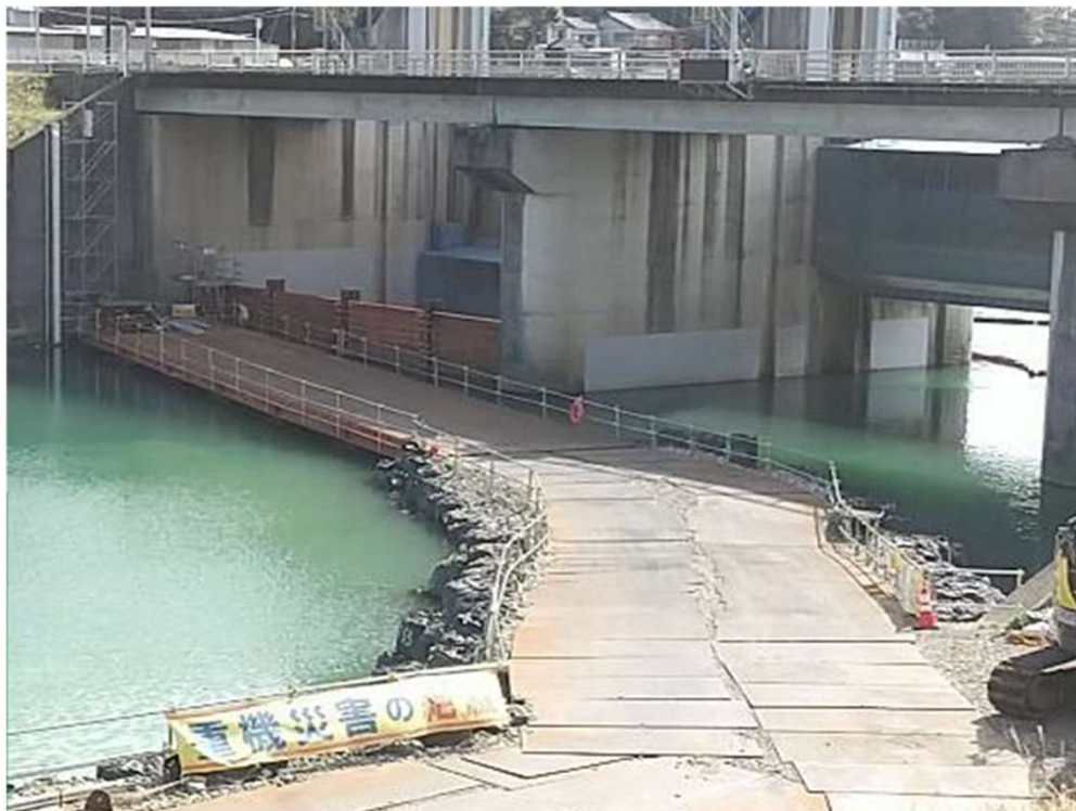
工所用道路設置状況
