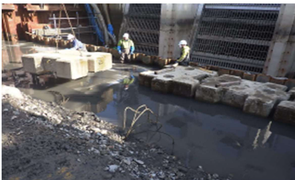
根固めブロック据え付け状況
