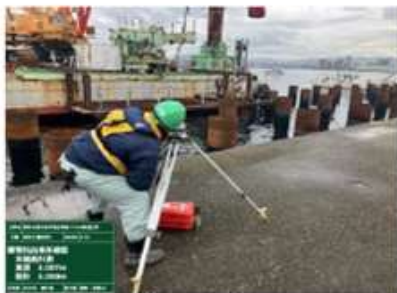
杭天端高 測定状況
