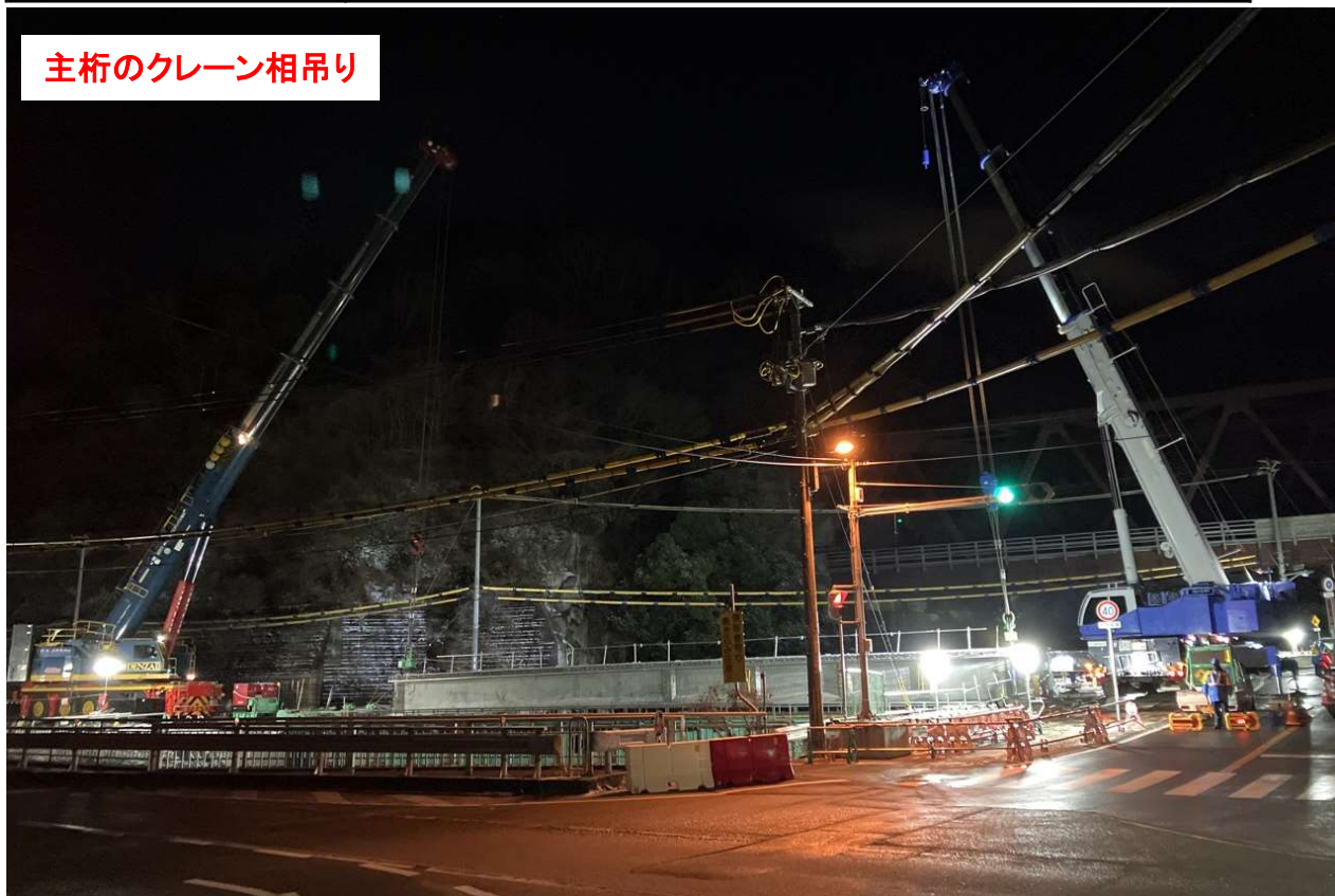
枝桁のプレキャスト化による工程短縮
