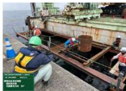
杭の傾斜 測定状況
