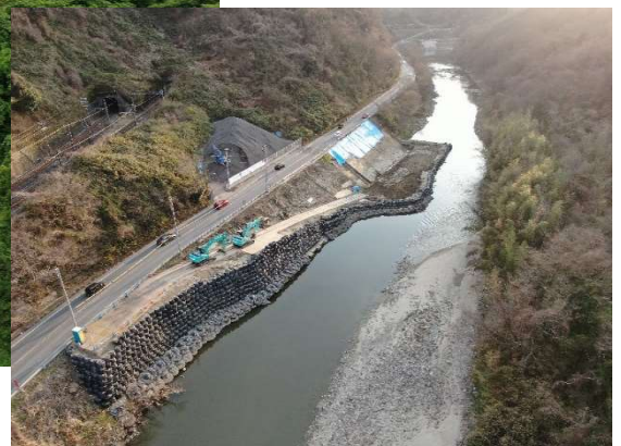
・天然路肩法面崩落の応急復旧状況
