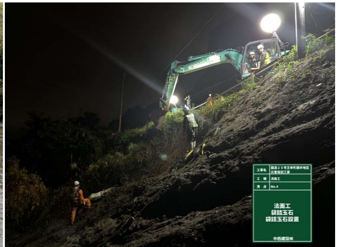
・天然路肩法面崩落の応急復旧状況
