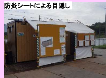
防災シートによる目隠し
