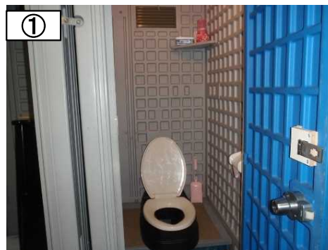
循環式洋式トイレ(男子トイレ)
