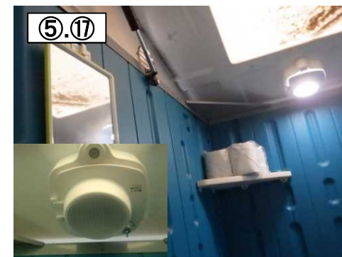
照明設備・小物置き場等
