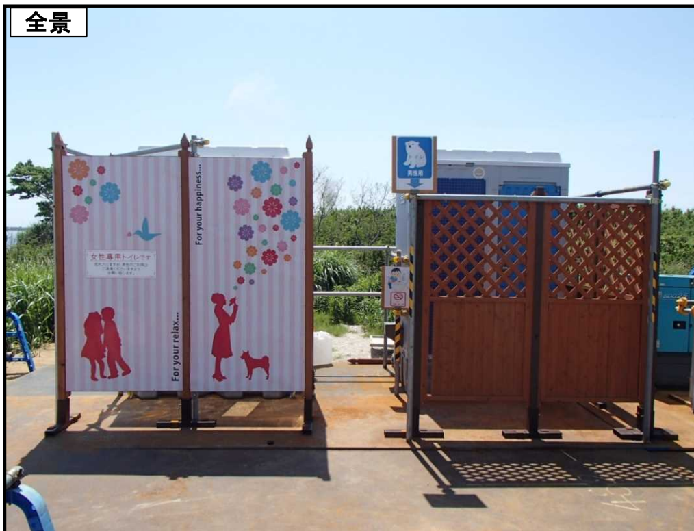
【男性用1基、女性用1基設置】
