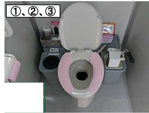
簡易水洗洋式トイレ 臭い逆流防止装置付き
