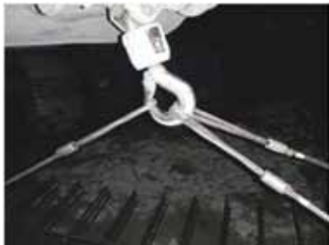
現場状況写真
