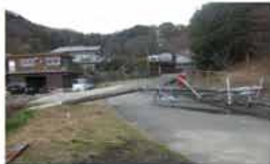
関西電力柱1本が倒壊
