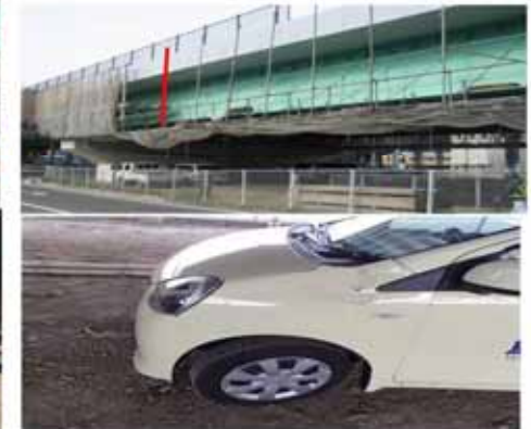
事故状況写真②
