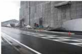
仮囲い転倒(被害なし)
