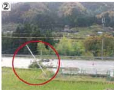
事故状況写真
