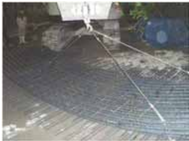
現場状況写真
