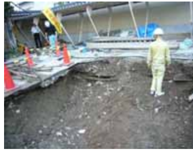
現場状況写真
