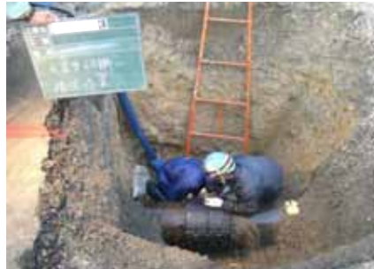
復旧状況写真
