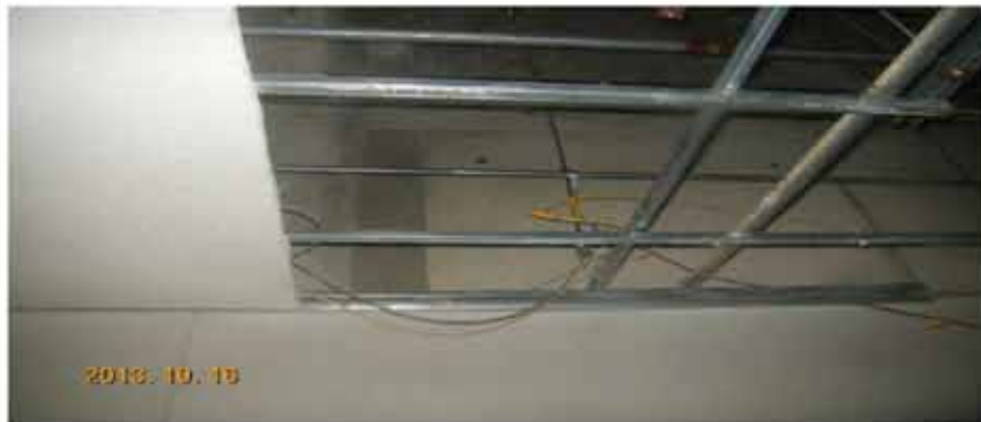
天井ボード解体状況
