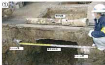
現場状況写真
