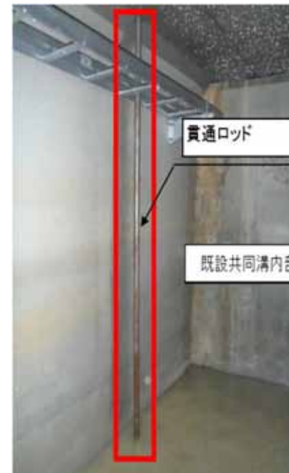
既設共同溝内部
