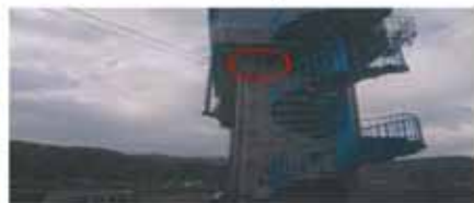
切断した引き込み線(水門側)
