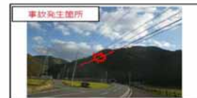
事故状況写真②
