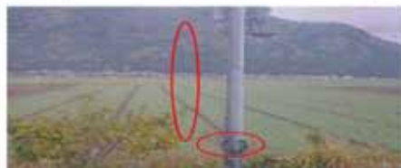
切断した引き込み線(電柱側)
