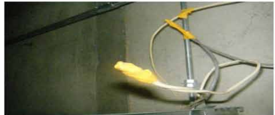
天井ボード解体状況
