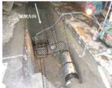
復旧状況写真
