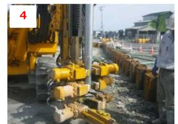
オペレータは、作業員の手上げ合図を確認後、レバーを操作し、第1クランプを締める
