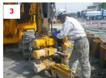
ビットのついたコアチューブを第2クランプの上に置き、作業員はマシンから離れてから手を挙げてオペレータに合図をする
