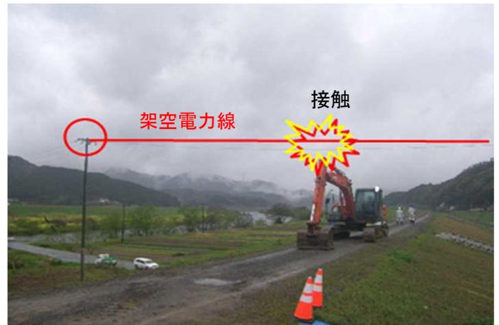
【事例3】降雨による増水に備えて、高水敷で作業中のBHを堤防天端に移動していたところ、堤防天端を架空横断していた関西電力の高圧電線3線(6,600V)のうち2線に移動中BHのアームが引っかかり断線させた。
