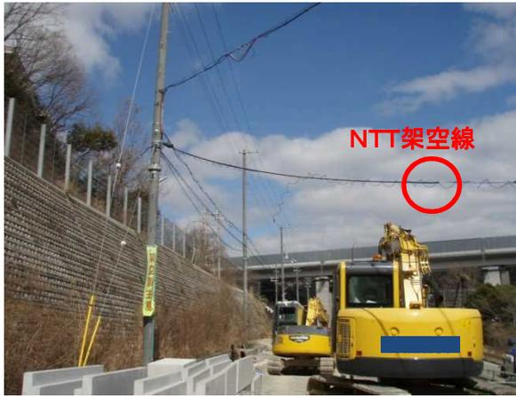
工用道路や河川管理用通路等で重機等の建設機械が一時的に通行する際、架空線への接触による損傷及び切断事故が多発しています。
