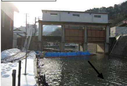
水門正面写真
