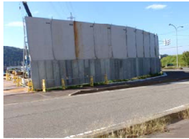
転倒前の設置状況
