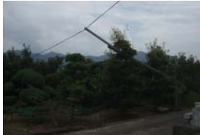
メッセンジャーワイヤー切断により倒れた電柱
