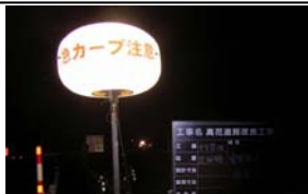
バルーン照明による危険周知
