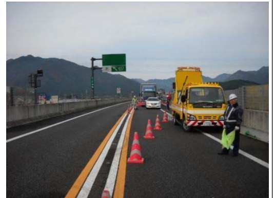
現場状況写真
