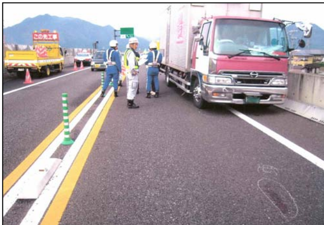
現場状況写真
