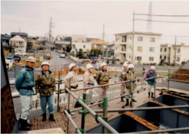
現場安全パトロールの様子
