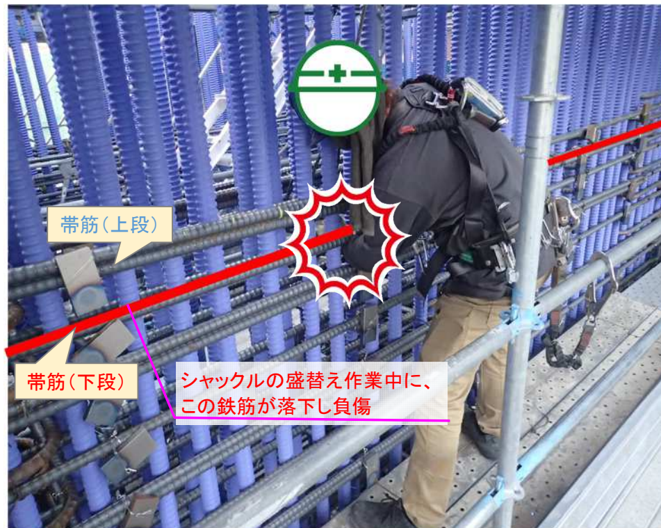
再現写真(帯筋設置完了の状態撮影)
