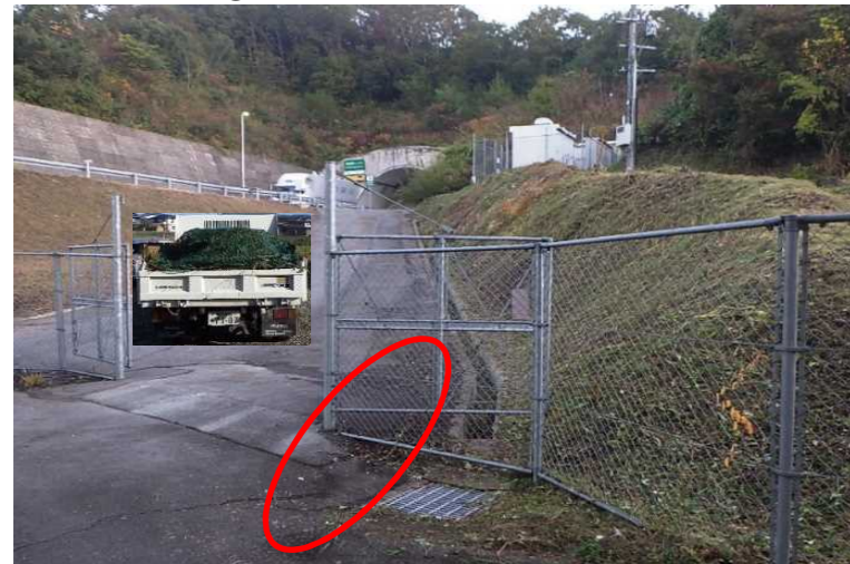
事故状況写真① (事故現場全景)
