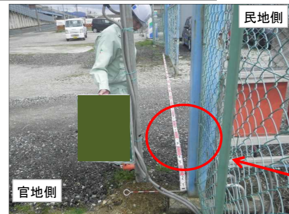
事故状況写真②
