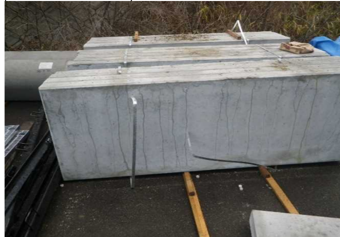
事故状況写真②
