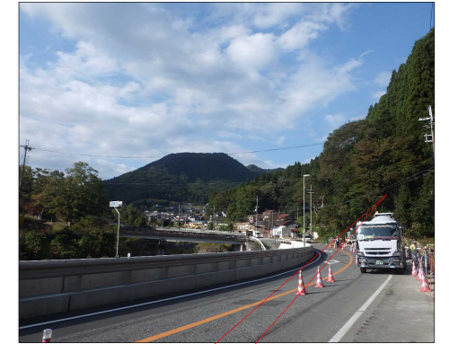
切断した架線
