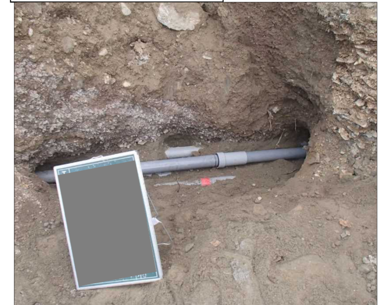
事故状況写真② (修復状況)
