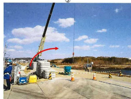
合図確認後、手前の仮置きしてあるブロックを越えながら川側へ旋回
