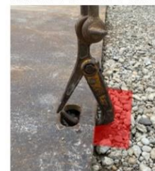
①フックを通すために、■部に穴を掃る。 ②フックを掛ける。
