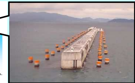
鋼板セル型防波堤
