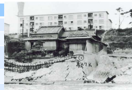
侵食被害(西八木地区)昭和33年頃
