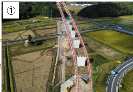
森本地区の状況（工事着手中）
