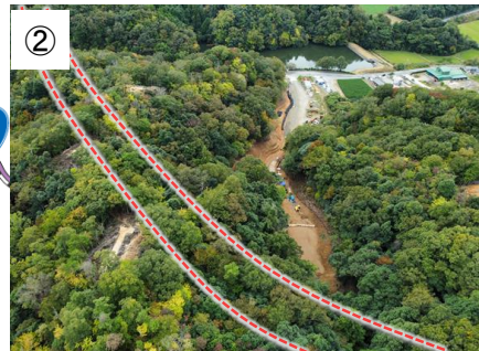
周枳地区の状況（一部工事着手中）
