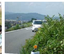
↑ 植生が繁茂し車から歩行者が見えにくい（取り組み前の様子）
