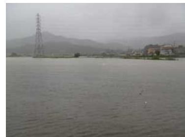
石居橋上流左岸堤内地
