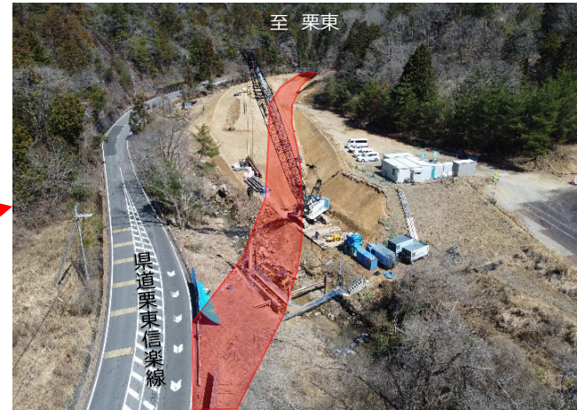
迂回路設置工事 現地状況 (令和8年3月時点)
