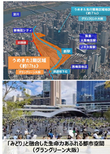
大阪駅周辺の再開発状況
