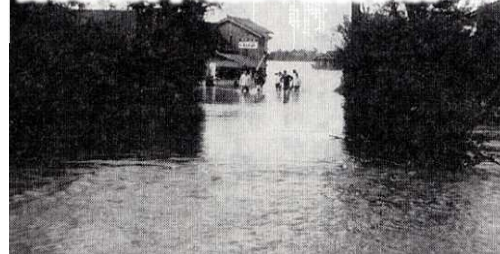
S28年9月洪水での 野洲川洲本地区の被害状況
