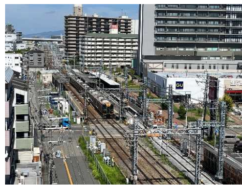
④ 仮上り線 福駅東側
