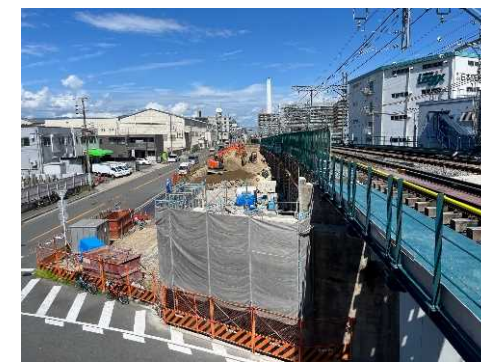
⑤ 既設線路敷撤去
