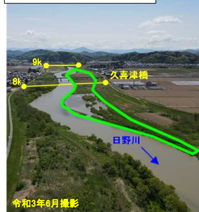
⑨片粕地区河道掘削
