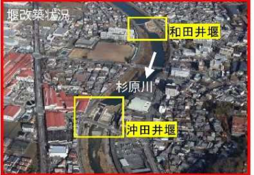
<堰改築事例(杉原川)>兵庫県
