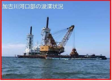
<河道掘削事例(加古川河口部)>姫路河川国道事務所
