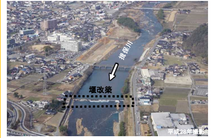
揖保川 中広瀬・今宿地区 堰改築
