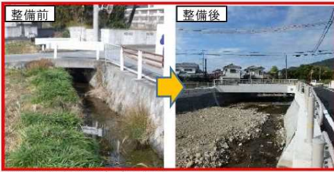
橋梁改築(山根川)(兵庫県)
