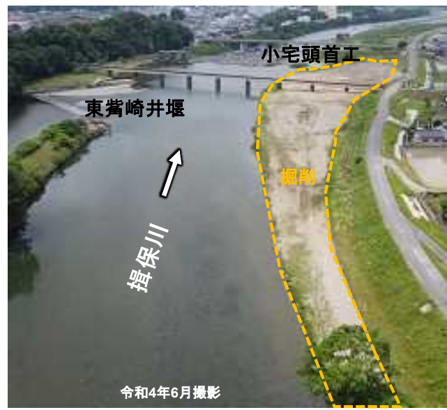
揖保川鯨崎地区 堰改築等
