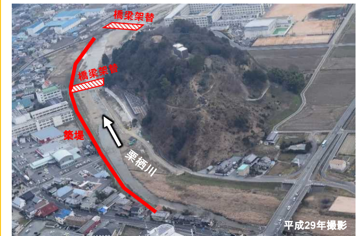
栗栖川 段之上地区 築堤、橋梁架替
