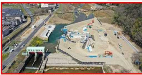
堰改築(林田川赤井頭首工)(姫路河川国道事務所)
