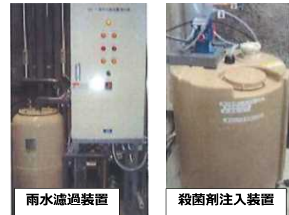
雨水利用設備 (機械室)
