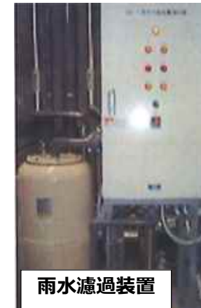
雨水利用設備 (機械室)
