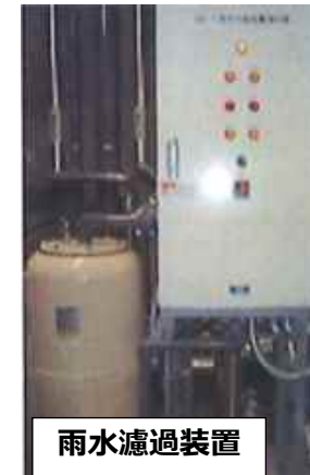
雨水利用設備 (機械室)
