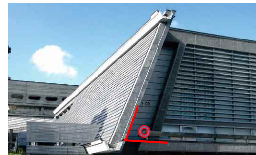
(参考) 本館外壁 頂部
