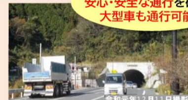
令和元年12月11日撮影 国道480号鍋谷峠トンネル(かつらぎ町平)
