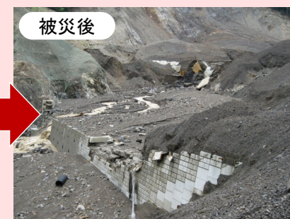
降雨時の土砂流出により砂防堰堤が破損
