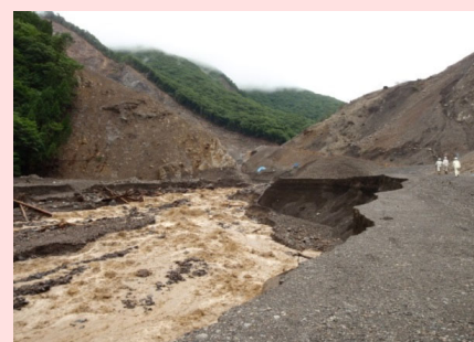
降雨後の下流河道の状況
