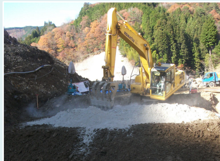
固化剤散布・混合
