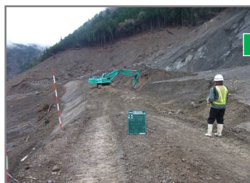
2011年 目視遠隔操作で土堤設置
