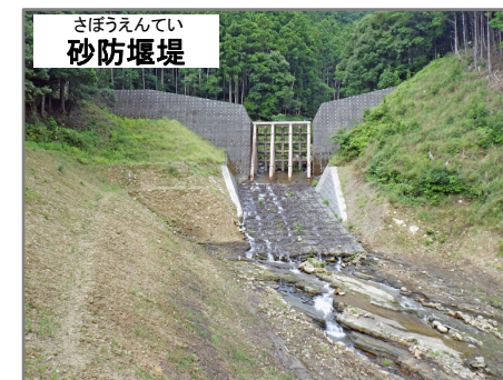
土石流発生時に流下する土砂や流木を捕捉する施設（平常時は土砂を流下させることが可能）
