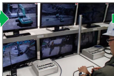
2015年 モニタ遠隔操作で排水管設置
