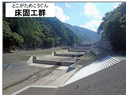
河床の侵食や河道に堆積している不安定土砂の再移動を抑えるとともに河道の乱れを整えて河岸の侵食や崩壊を防ぐ施設
