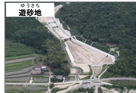
流路の拡幅や堀込みにより縦断勾配を緩和し、流出土砂を堆積させる施設
