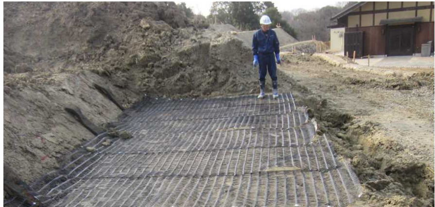
盛土補強材の設置
