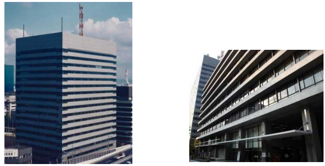
大阪第4地方合同庁舎(1993完成) 大阪第2地方合同庁舎(1968完成)
