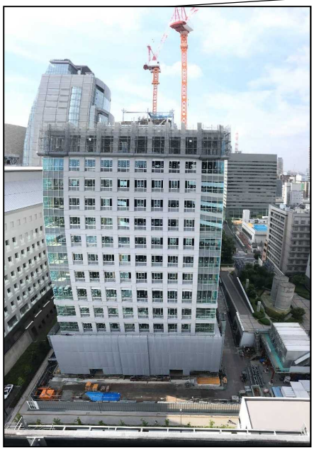
現況写真(敷地北側より)
