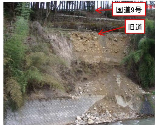
▲平成15年度の災害状況 〔国道9号法面下の旧道崩壊〕
