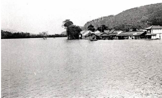
おうじちょう 【 家屋の湛水被害状況(王寺町) 】
