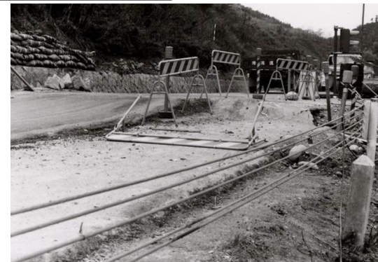
【 国道25号の隆起による被害状況 】
