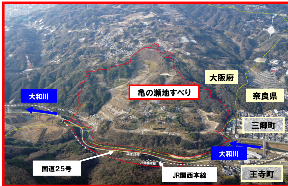
【 亀の瀬地すべり周辺の状況 】
