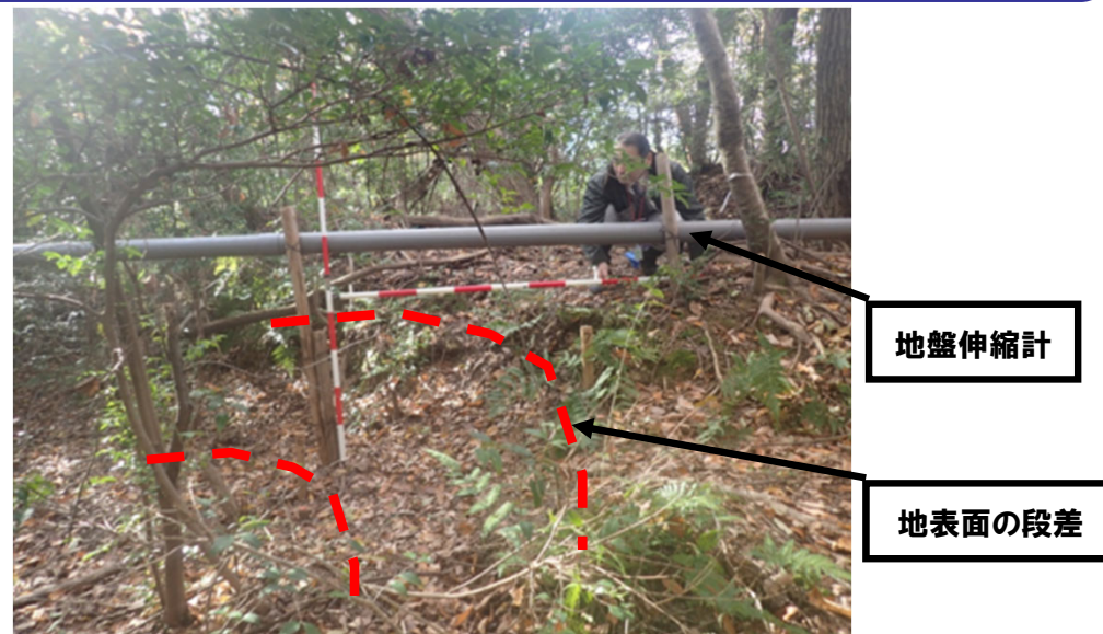
【 稲葉山地区における計測状況及び地表面の段差 】
