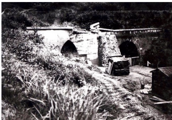
【 旧鉄道省関西本線トンネルの崩壊 】
