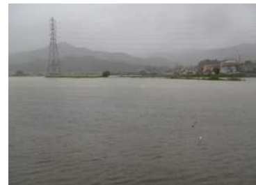
石居橋上流左岸堤内地
