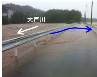
石居橋上流左岸側
