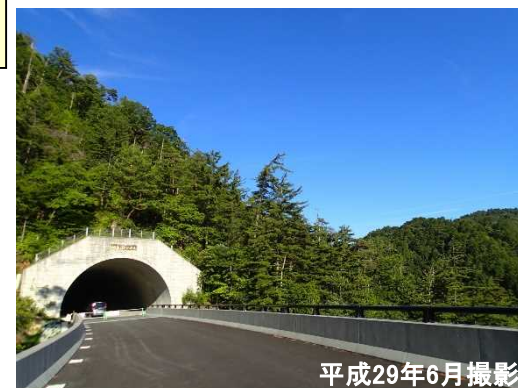
付替県道大津信楽線 桐生辻1号と新8号橋
