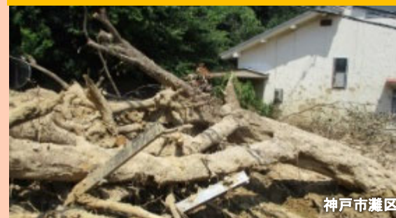
平成30年7月豪雨災害の被害事例
