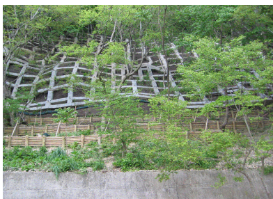
現存植生を保全した法枠工
