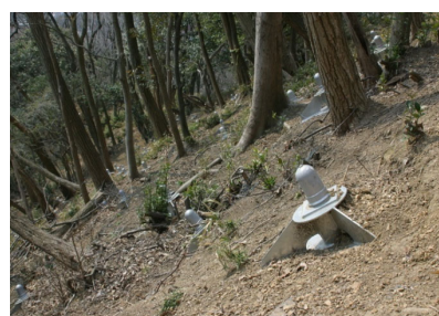
鉄筋挿入工
