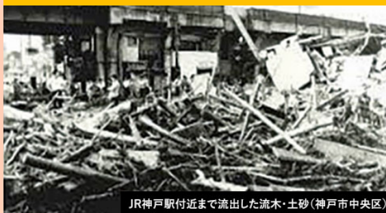
昭和42年7月豪雨災害の被害事例
