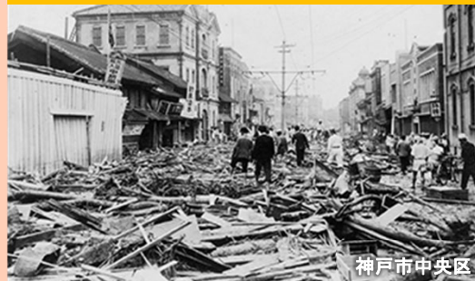
昭和13年阪神大水害の被害事例
