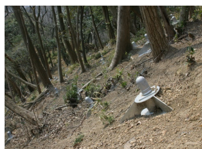
鉄筋挿入工
