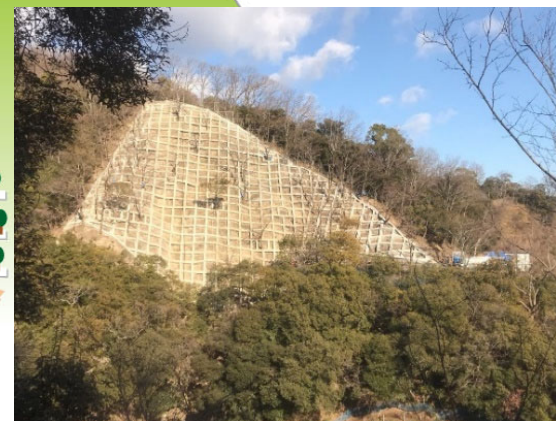
現存植生を保全した斜面对策工 ふきあい しんいくた 葺合地区(新生田川水系)
