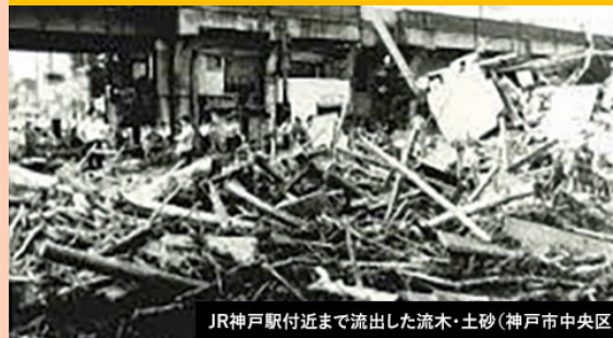
昭和42年7月豪雨災害の被害事例
