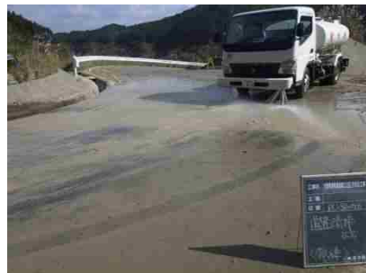
散水車による散水 (工事中の粉じんの発生を抑制)
