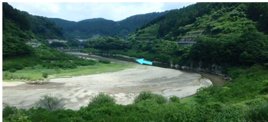
比奈知ダム上流部の堆砂の様子 (H29.7撮影) : 矢印は流れを示す
